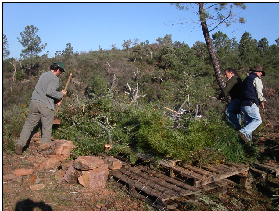
Figura 85 – Construção de marouços com paletes de madeira, rede “malha sol” e ramos.
