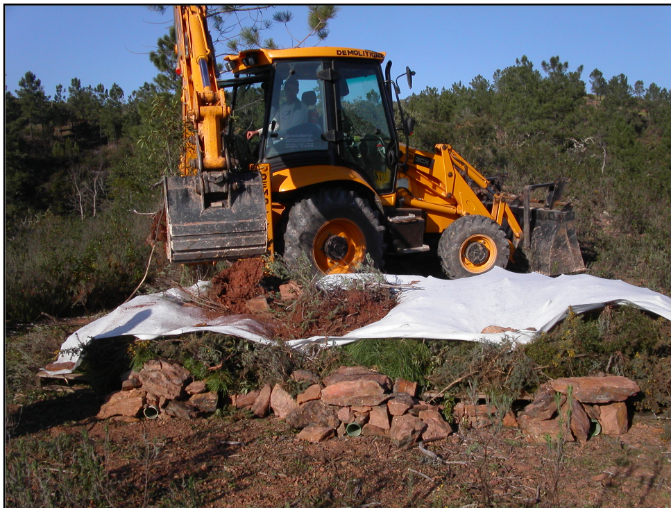
Figura 86 – Isolamento do marouço com geotêxtil e posterior cobertura com terra.
